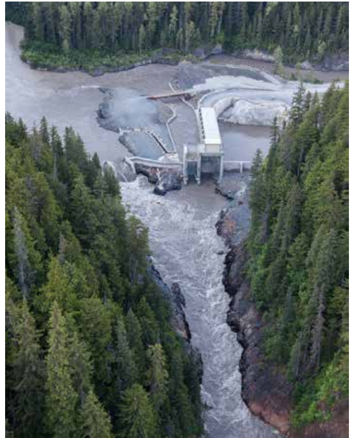
La centrale hydroélectrique de Forrest Kerr, en Colombie-Britannique, a vu le jour grâce à une entente entre la société AltaGas et la nation Tahltan. PHOTO COURTOISIE ALTAGAS
