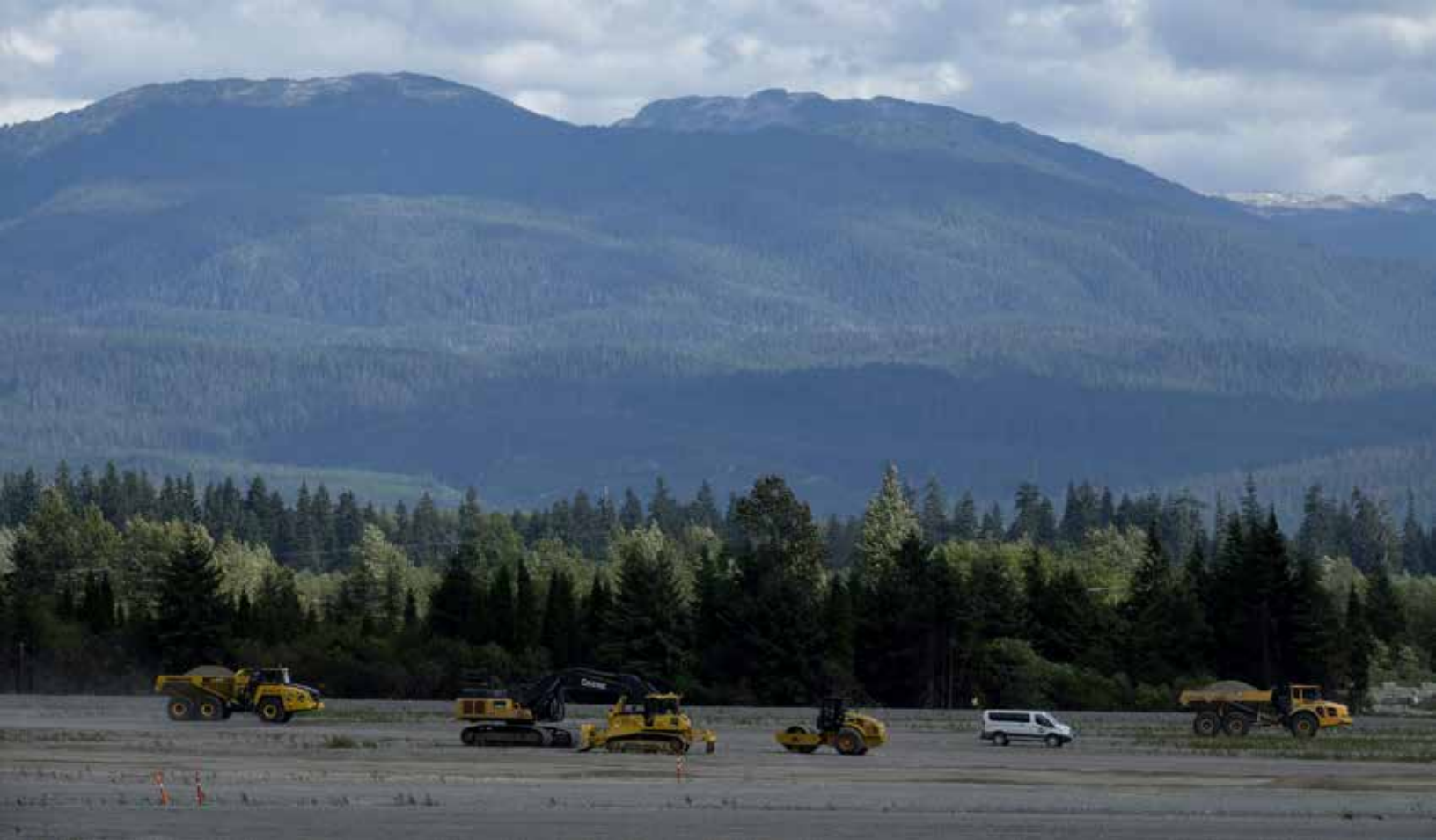
À l'été 2018, les travaux sont en cours sur le site d'un futur camp de travail, à Kitimat, en Colombie-Britannique, en prévision de la réalisation du projet LNG Canada. PHOTO ROBIN ROWLAND, LA PRESSE CANADIENNE
