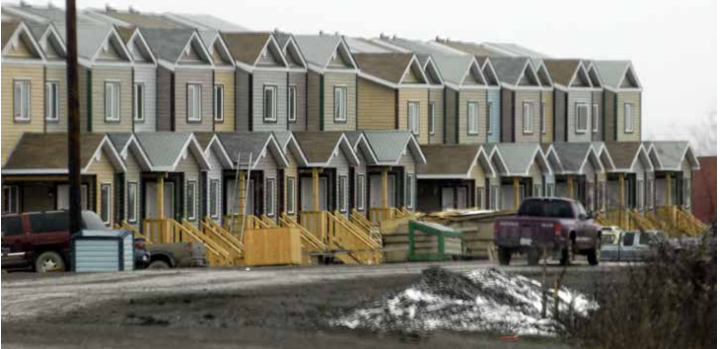
La construction de nouvelles maisons à Inuvik, dans les Territoires du Nord-Ouest, avait débuté en anticipation de l'activité économique importante que devait générer la construction du pipeline de la vallée du Mackenzie. PHOTO FRED LUM, THE GLOBE AND MAIL DIGITAL IMAGE
